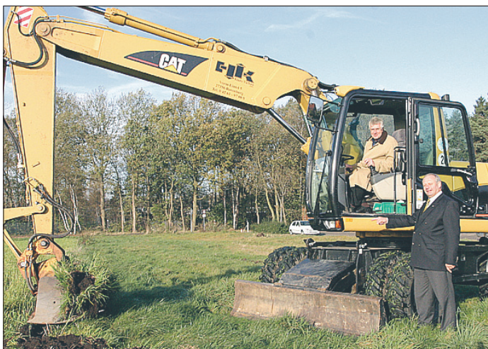
Schwanewedes Bürgermeister Harald Stehnken, hier mit GEWOSIE-Vorstand Axel Utrata, übernahm den ersten Baggerstich auf dem Baugebiet Tilsiter Weg.
